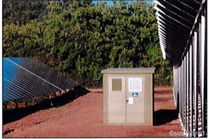
Poste de transformation vu de côté (source : étude d'impact)
