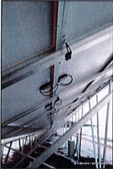
Câblage sous les modules
