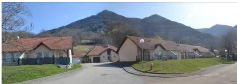
la résidence Assin : 10 logements intermédiaires sociaux
