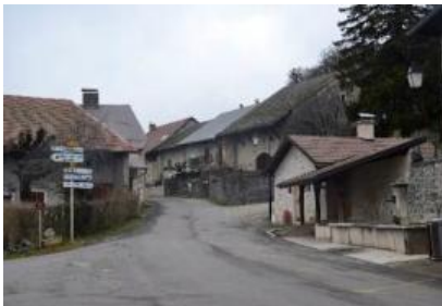
Le centre est marqué par de grosses constructions et une continuité bâtie alignée sur la RD69
